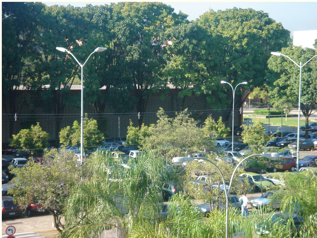
Figura 5.2: Prédio Antigo do ICEX
